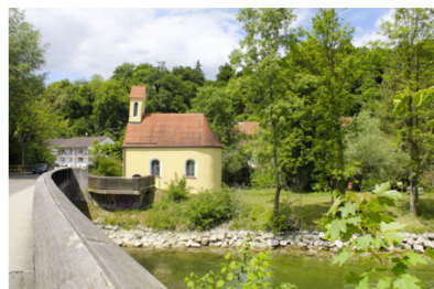
St. Nikolauskapelle an der Amper
