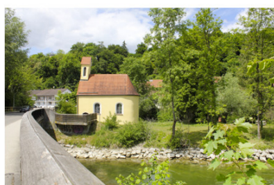
St. Nikolauskapelle an der Amper
