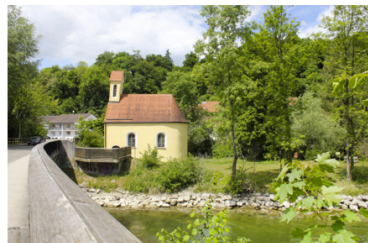
St. Nikolauskapelle an der Amper
